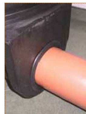
DETALJ SPOJA PVC CIJEVI I PEHD OKNA
